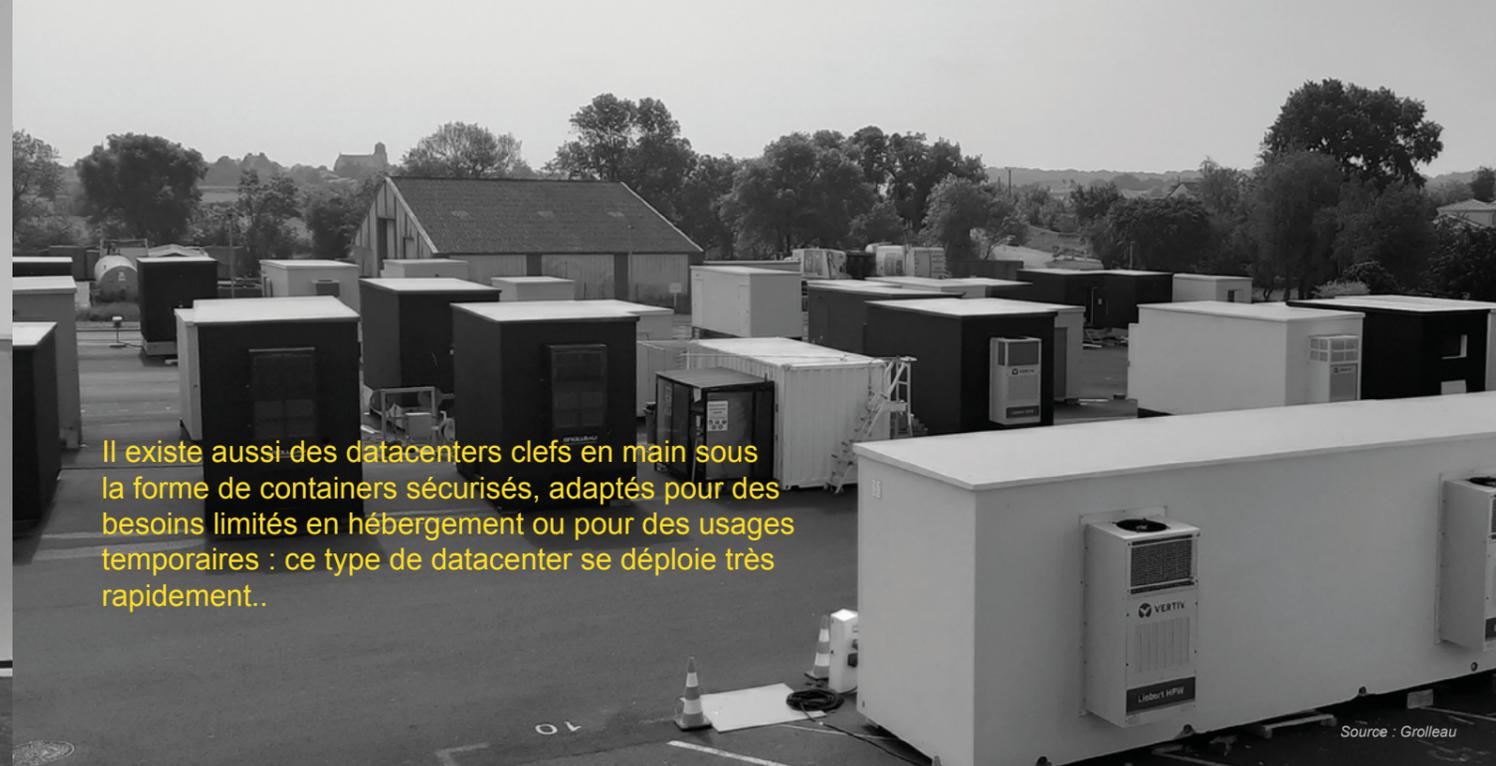
Il existe aussi des datacenters clés en main sous la forme de containers sécurisés, adaptés pour des besoins limités en hébergement ou pour des usages temporaires : ce type de datacenter se déploie très rapidement..
